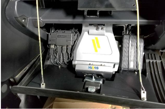
Installation de la nouvelle porte
